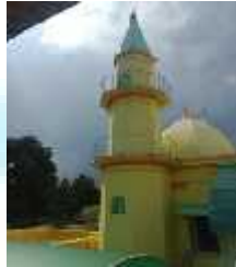
Gambar 2 Bentuk Menara Pada Masjid Raya Sultan Riau Penyengat
